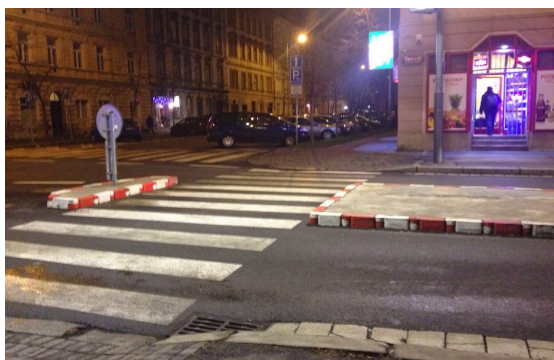
Attraversamento con "isola salvagente" e attraversamento rialzato
